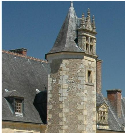
**baie** : ouverture pratiquée dans un mur ou dans un assemblage de charpente pour faire une porte, une fenêtre.
